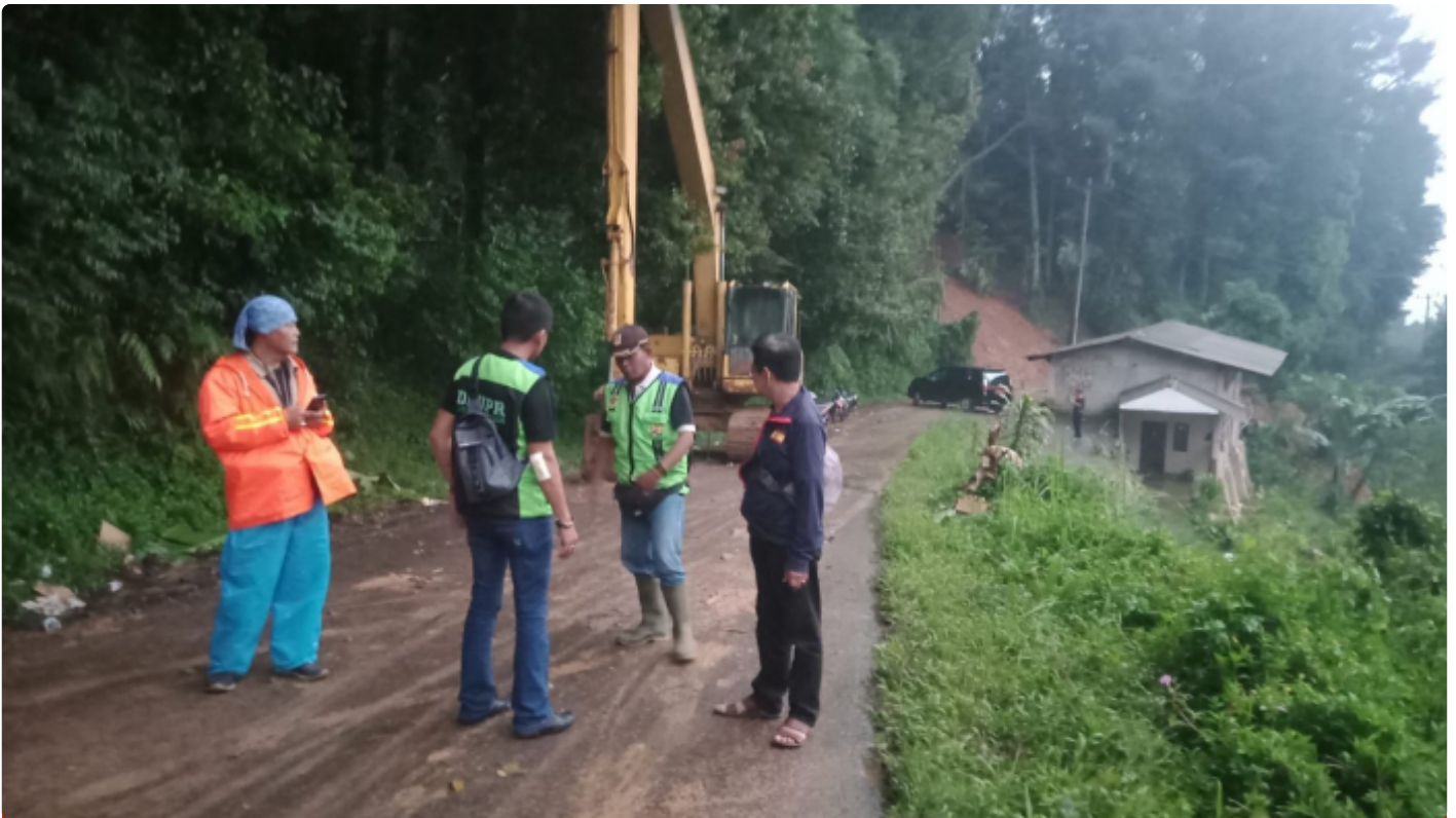
Tim UPT Insfratraktur Jalan Dan Jembatan Wilayah Leuwiliang saat melakukan evakuasi jalan.
